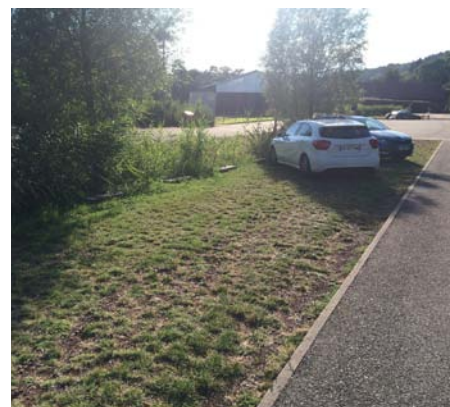
Traitement de sol enherbé (places hors circulation)
