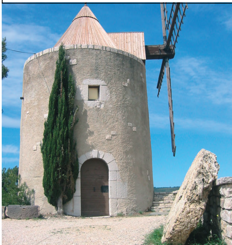
Le moulin à vent de Ventabren © AUPA - 2007
