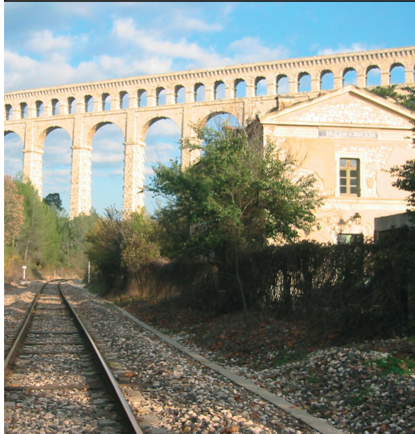
l'ancienne gare de Ventabren (au premier plan)
