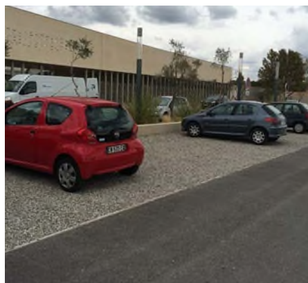
Traitement de sol par graviers (places hors circulation)
