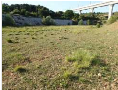
Bassin de rétention vidé
