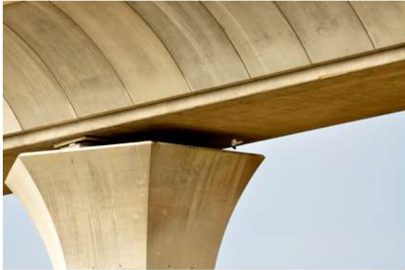
Pigeons domestiques à l'état sauvage sous le plateau de la Ligne TGV
