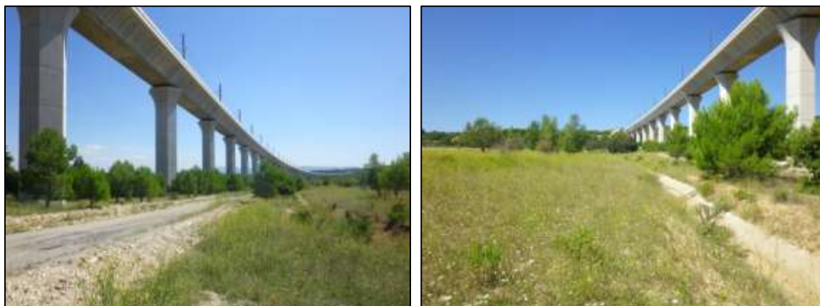
Viaduc, piste, pins et friche sur la frange est du terrain.
