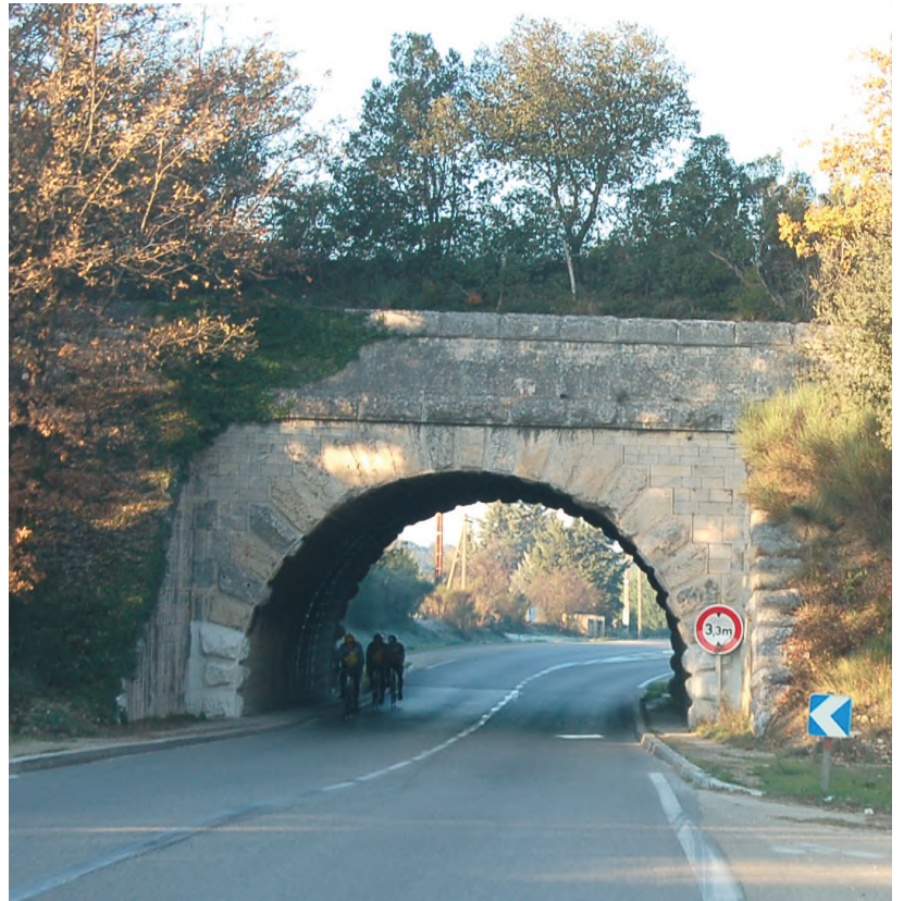
Le pont du canal de Marseille et la RD10
