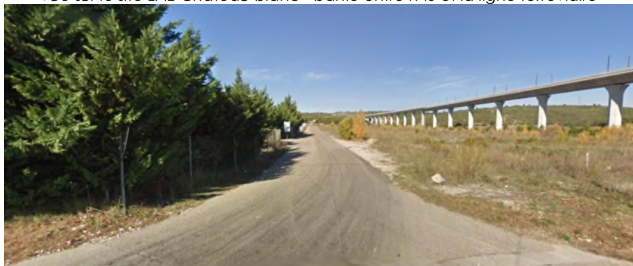
Vue sur le site ZAE Château blanc - partie entre l'A8 et la ligne ferroviaire
