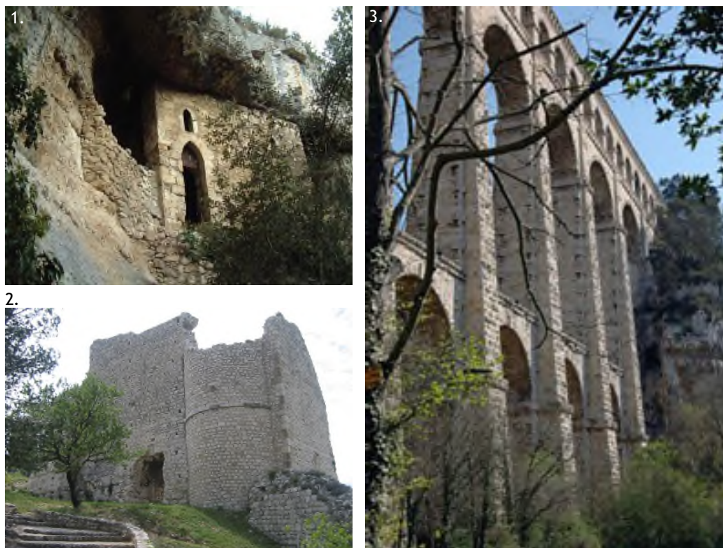
Figure 6 : Monuments Inscrits à l'Inventaire des monuments historiques - 1. L'Hermitage Saint Honorat de Roquefavour, 2. Le Château de la Reine Jeanne, 3. L'Aqueducde Roquefavour Source : www.ventabren.fr
